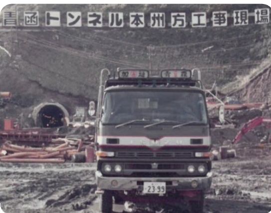
いまや新幹線も走る青函トンネル。多くの労働者が殉死した難工事でもありました。
