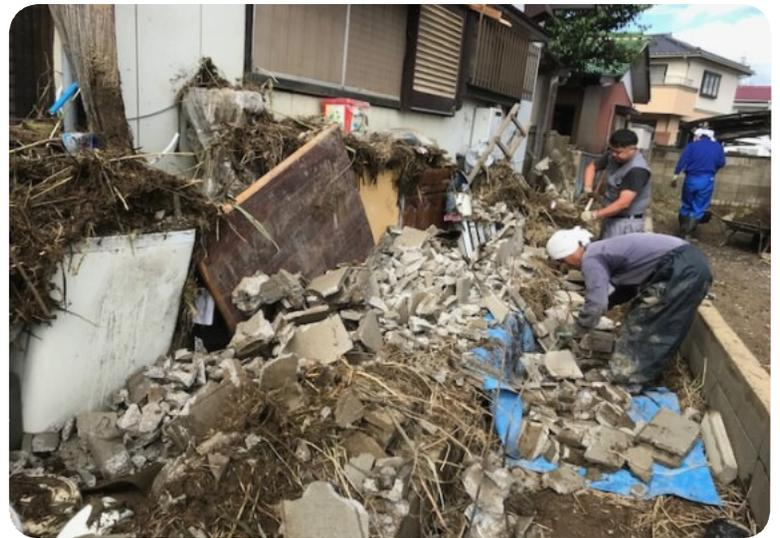
水圧で押し倒されたブロック塀の撤去作業
