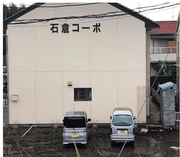
福島県阿武隈川周辺の様子。駐車中の車の上まで水が押し寄せました(10月15日)
