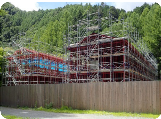
登山基地樫島に建設中の立派な作業員宿舎
