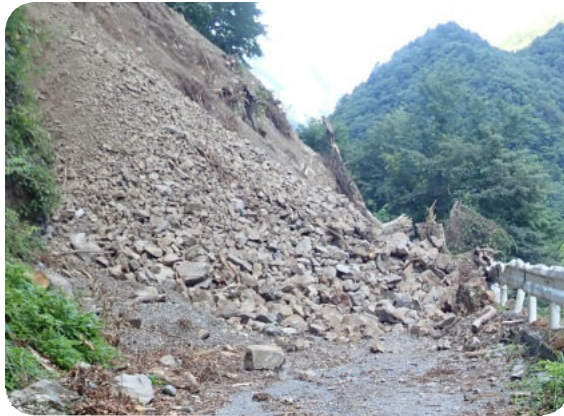
台風と豪雨によって各所で崩落事故続発
