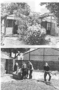
公園詰所と倉庫への跡片付け
