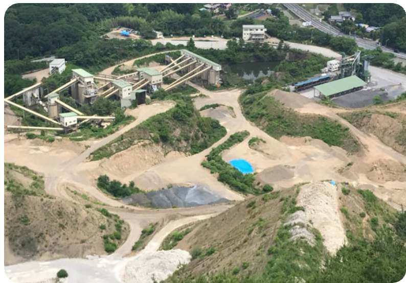
近年まで設備投資を行っていた関野建材の足利鉱山
