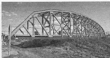
● 次は、さらに南に下がり宇治川に出ると巨大な鉄橋が川をまたいでいます。宇治川に沿って外環状線を走ると近鉄電車の線路として、この鉄橋はよく目にしますが、正式には「澣川鉄橋」といって、長さ165mで、橋脚の高いトラス橋（三角の組み合わせ）。逸話として紹介されたのは、1928年に、京都で行われた昭和天皇即位の礼に間に合わせようと、当時の奈良電車が建設したのですが、建設申請に陸軍が「工兵隊の渡河や架橋訓練の邪魔、河や
