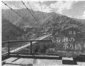
谷瀬の吊り橋
