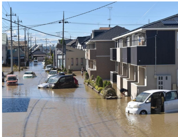
2019年台風19により県内でも大きな被害が発生
