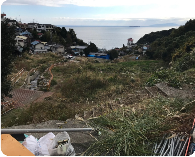
11月25日熱海市崩落現場を視察。住宅再建は進まず更地のまま。被災者の苦しみは続いています。
