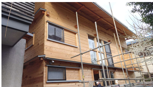
奥行1.5mの軒は夏の直射日光を防ぎ冬の日差しを取り入れます
