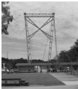
吊り橋の主塔
