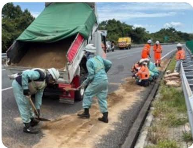
地元建設業者・ダンプ労働者が復旧工事の担い手。（熊本県宇城市の道路ひび割れ復旧現場）
